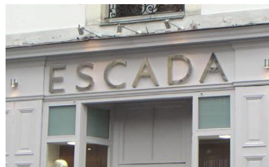
Lettres découpées posées directement sur la façade
